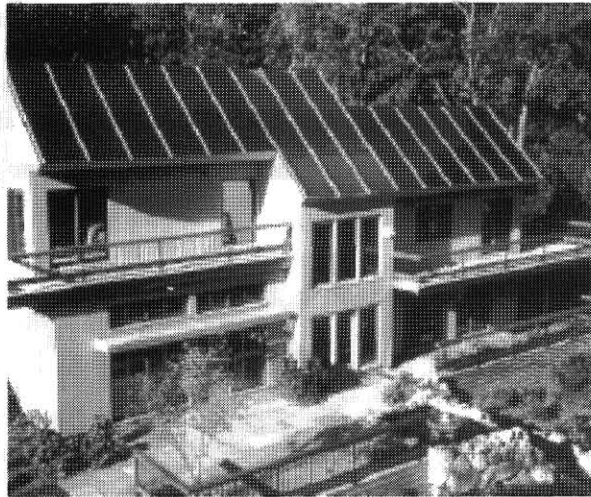
شكل (١٠ أ ب) : تنوع الطاقة الشمسية بمختلف تطبيقاتها، هذا المنزل في مدينة بوسطن بولاية ماسشوسيتس (تصميم جمعية التصميم الشمسي) يوضح التصميم المطبق لتحسين كفاءة استخدام الطاقة، والإضاءة بضوء النهار، والتدفئة الشمسية الخاملة المباشرة، والتدفئة الشمسية الغير مباشرة، وتسخين المياه، وتوليد الكهرباء بالطاقة الشمسية، كل هذه التطبيقات تم تكاملها داخل المنزل ليصبح منزلاً لا يستهلك سوى الطاقة الشمسية فقط. من المهم أيضاً استخدام الطاقة الشمسية في الضروريات الرئيسية مثل استخراج المياه العذبة، الإضاءة، حفظ الدواء في ثلاجات بالنسبة للدول النامية، والصورة على اليمين لطلبة شمسية لضخ المياه في الهند.
